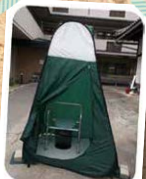
マンホールに直接汚物を流すマンホールトイレ。
