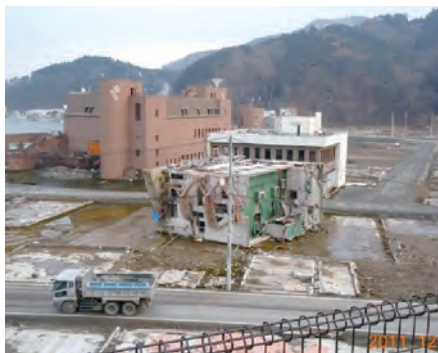
おながわ 石巻女川地区の横転したビル
